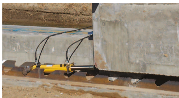
Verschub einer Brücke mit RR-Zylindern.
